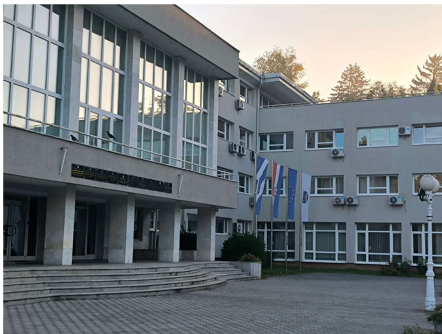
Slika 4. Zgrada Brodsko–posavske županije, Županijske skupštine BPŽ i tijela javne uprave
